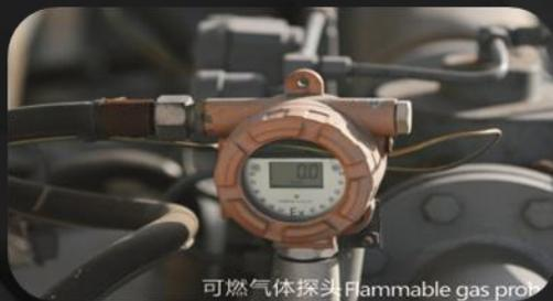
可燃气体探头 Flammable gas probe
